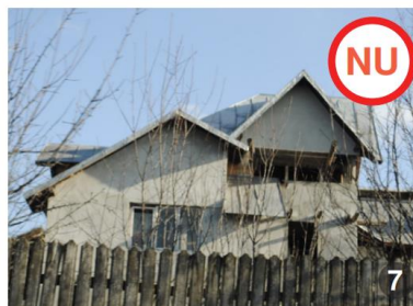
AȘA NU: Soluția acoperișului „jucat” al clădirii noi contrastează puternic cu sobrietatea clădirilor tradiționale.
